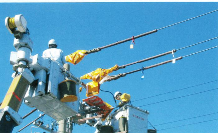
配電線工事は高所作業や活線作業（通電中の電線を扱う）を伴うため、万全な安全対策が必要です。トーエネック配電協会では、最新の機械設備、安全工具を採用することで作業者の安全を第一に考えています。またトーエネックと共に「間接活線工法」「仮送電工法」などの施工技術を開発、実用化しながら安全かつ効率的な作業を追求しています。
